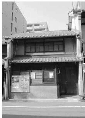
修復前の外観
