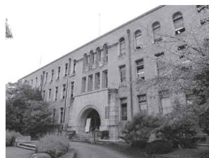
本格移転先 現京都府警察本部本館
