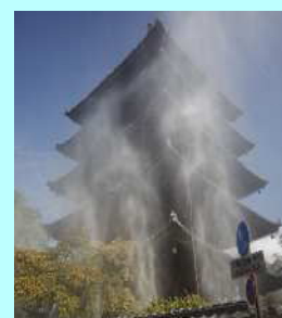
法観寺境内に整備した 文化財延焼防止放水システム
