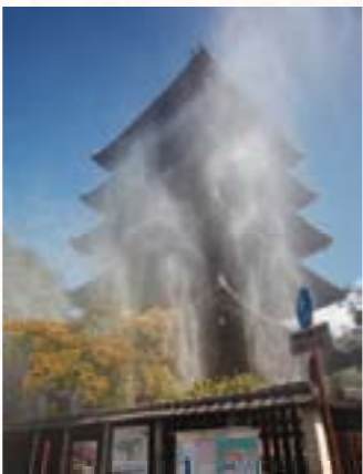
▲法観寺境内に整備した文化財延焼防止放水システム
